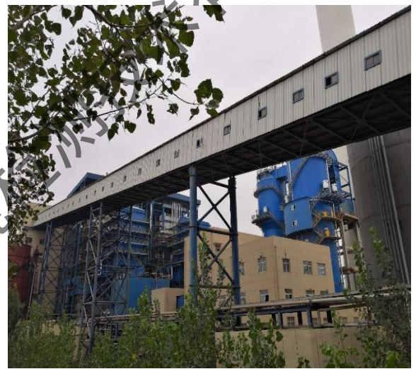
热电站封闭的输煤皮带走廊
