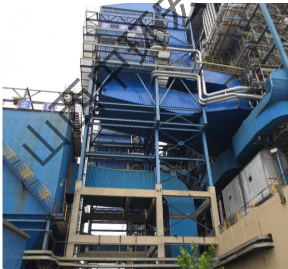
2#炉 SCR 脱硝
