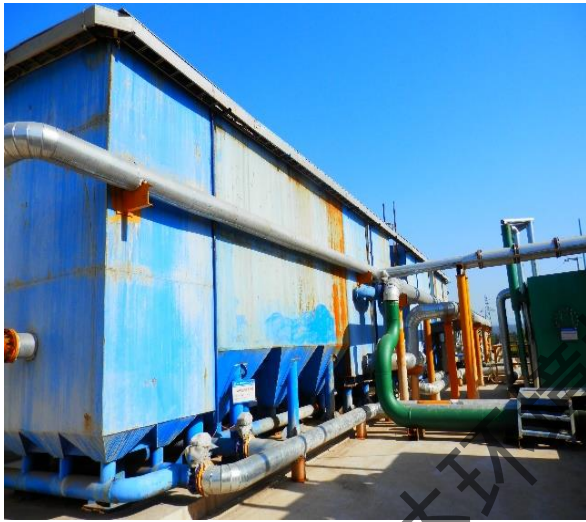
生产废水一体化高速净水器
