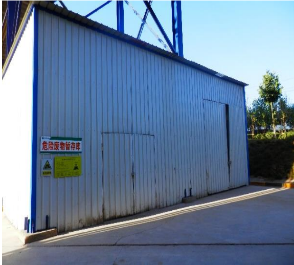
废机油暂存库
