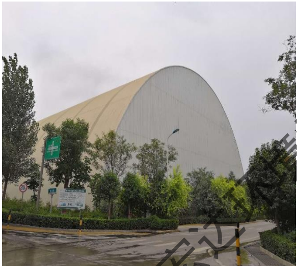
全封闭的原料均化库
